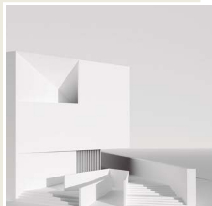
Estado actual de las obras. Debajo, imagen del proyecto final.
