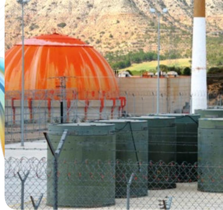
**La central nuclear de Trillo cuenta desde 2002 con un Almacén Temporal Individualizado en seco** en el que a 31 de diciembre de 2018 se encontraban 34 contenedores (32 del tipo DPT con 21 elementos combustibles cada uno y 2 del tipo ENUN32P con 32 elementos combustibles cada uno) con un total de 736 elementos combustibles irradiados, lo que supone un grado de ocupación del 33,3%.
