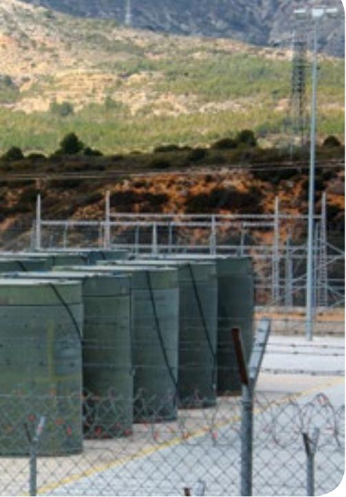
**La central nuclear de Almaraz cuenta, desde diciembre de 2018, con un Almacén Temporal Individualizado en seco.** El 12 de diciembre se completó la carga y el traslado del primer contenedor, del tipo ENUN32P, con un total de 32 elementos combustibles irradiados procedentes de la piscina de la unidad I.
