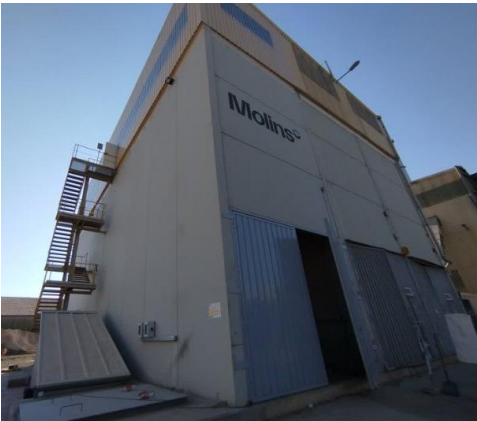
Almacenamiento de combustibles alternativos en la planta de Barcelona.
