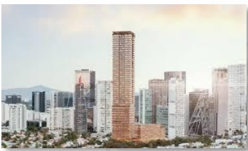
Suministro de hormigón para la torre Legend en Guadalajara.
