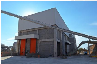
Instalación de almacenamiento y transformación de combustibles alternativos de Tepetzingo.
